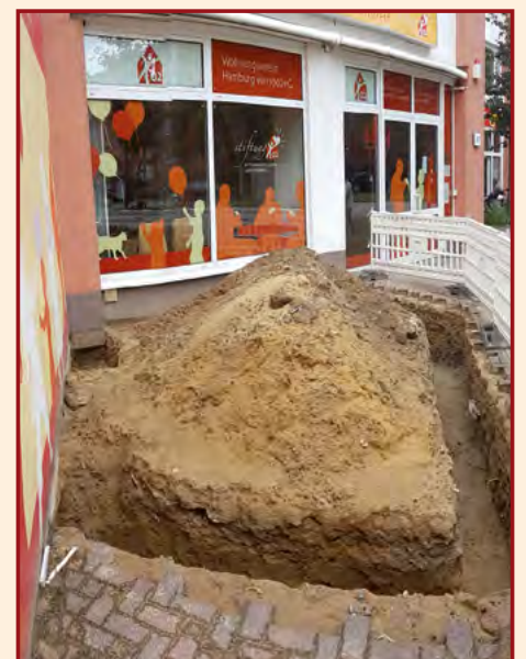
Das Fundament für den 16 m 2 großen Büroraum ist vorbereitet.
